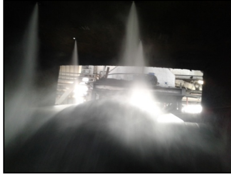
Fig 8: Dry Fog Dust suppression sytem
